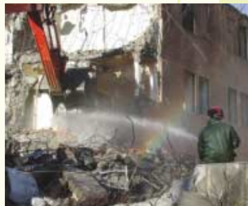
Under rivingen må støvet bindes med vann.
