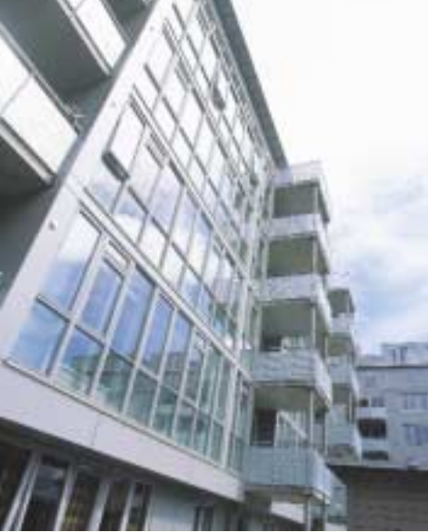
Klosterenga økologiboliger. Bildet viser den doble glassfasaden mot syd - for utnyttelse av solenergi. Foto: Ole Walter Jacobsen
