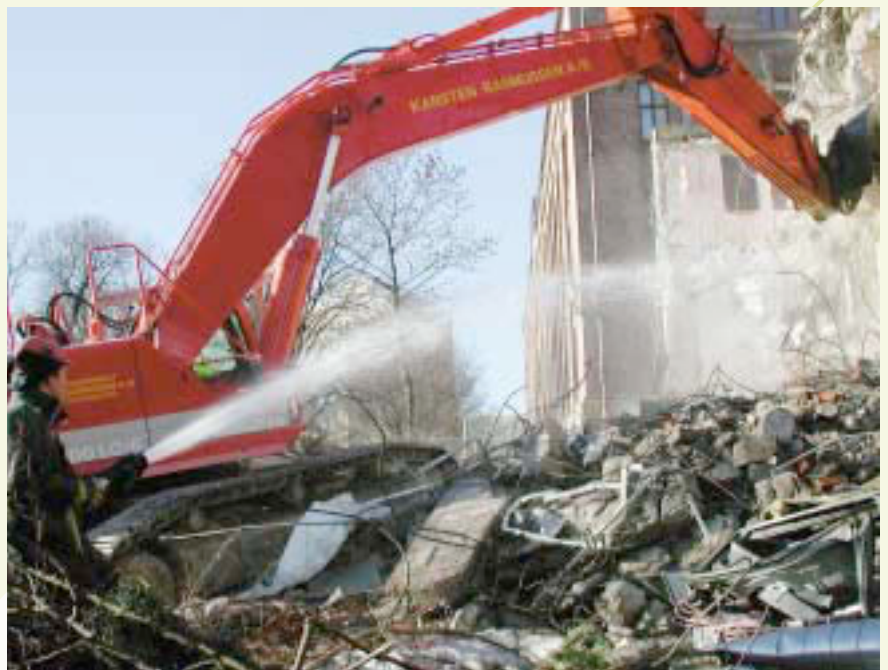
Støvet bindes med vann under rivingen.
