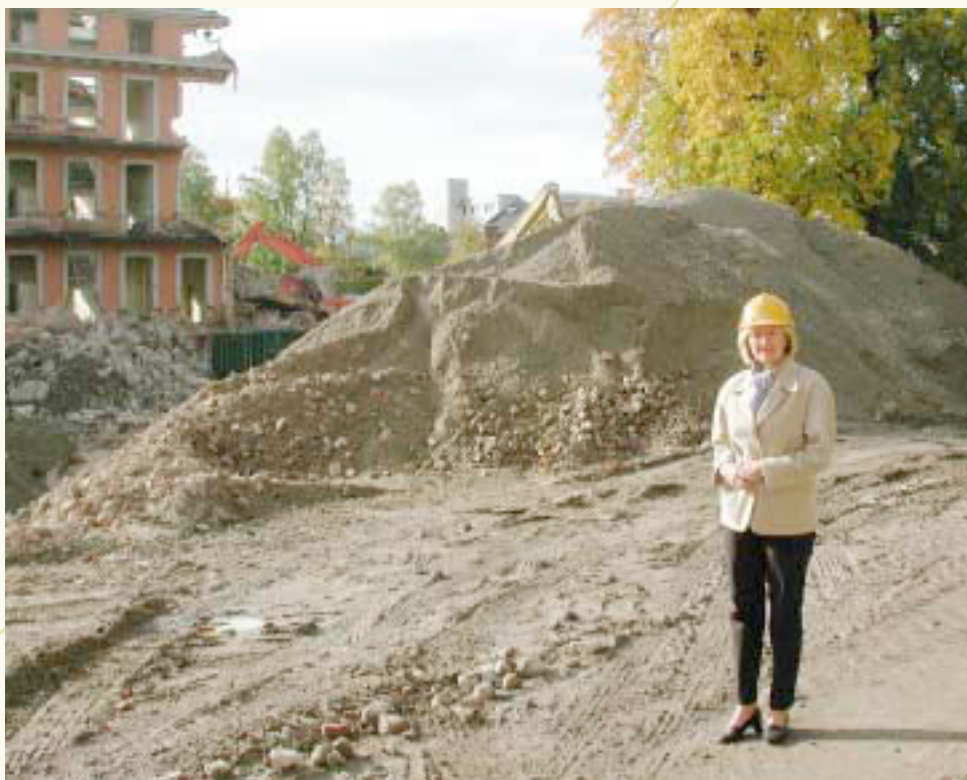
Byråd Ann Kathrine Tornås ble imponert av byggeplassen i Pilestredet Park.
