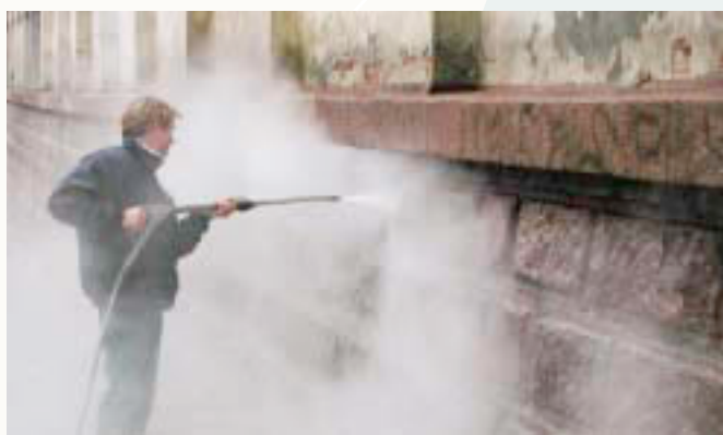
Vasking av muren.
